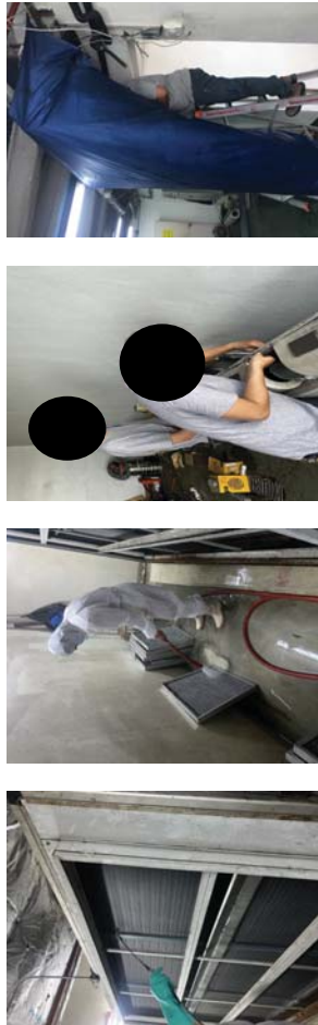
การล้างทำความสะอาดเครื่องปรับอากาศ
